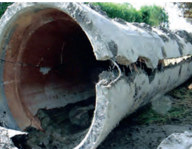
Abb. 7 – Geborstene Spannbetonrohre sind nicht nur eine theoretische Gefahr: Bei mehr als zehn Spanndrahtbrüchen in einem Segment droht die Vorspannung das Rohrsegment zu sprengen und eine Kettenreaktion auszulösen.
