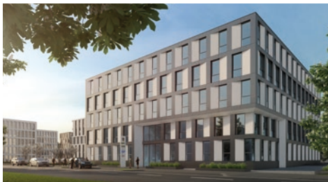
EASTSITE IV BAUJAHR 2012 / 2013 BÜROFLÄCHE 4.200 M 2
